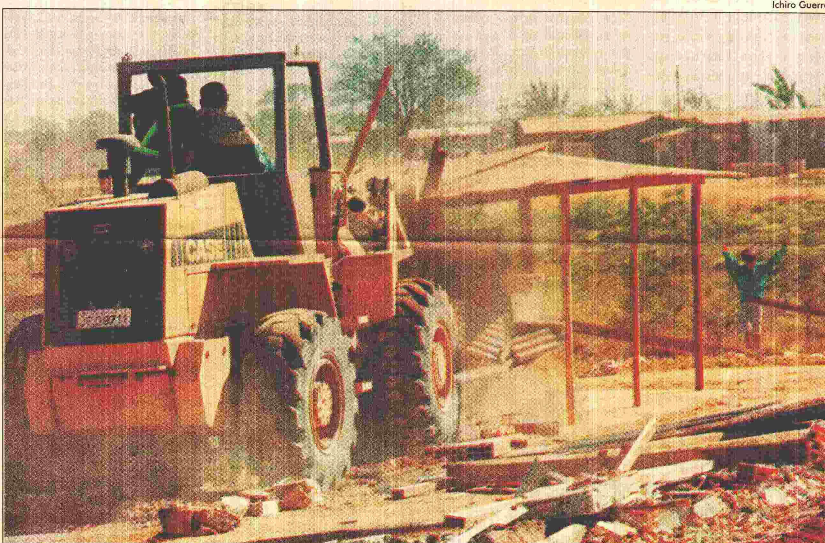
Quatro tratores foram usados para derrubar barracos e um muro que cercava diversas casas. GDF promete remover construções de alvenaria
