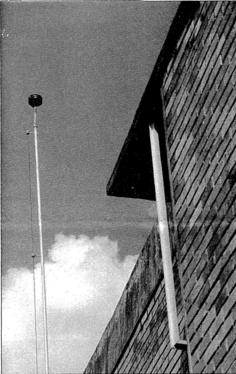
O pára-raio radioativo não é eficiente e representa risco à saúde
