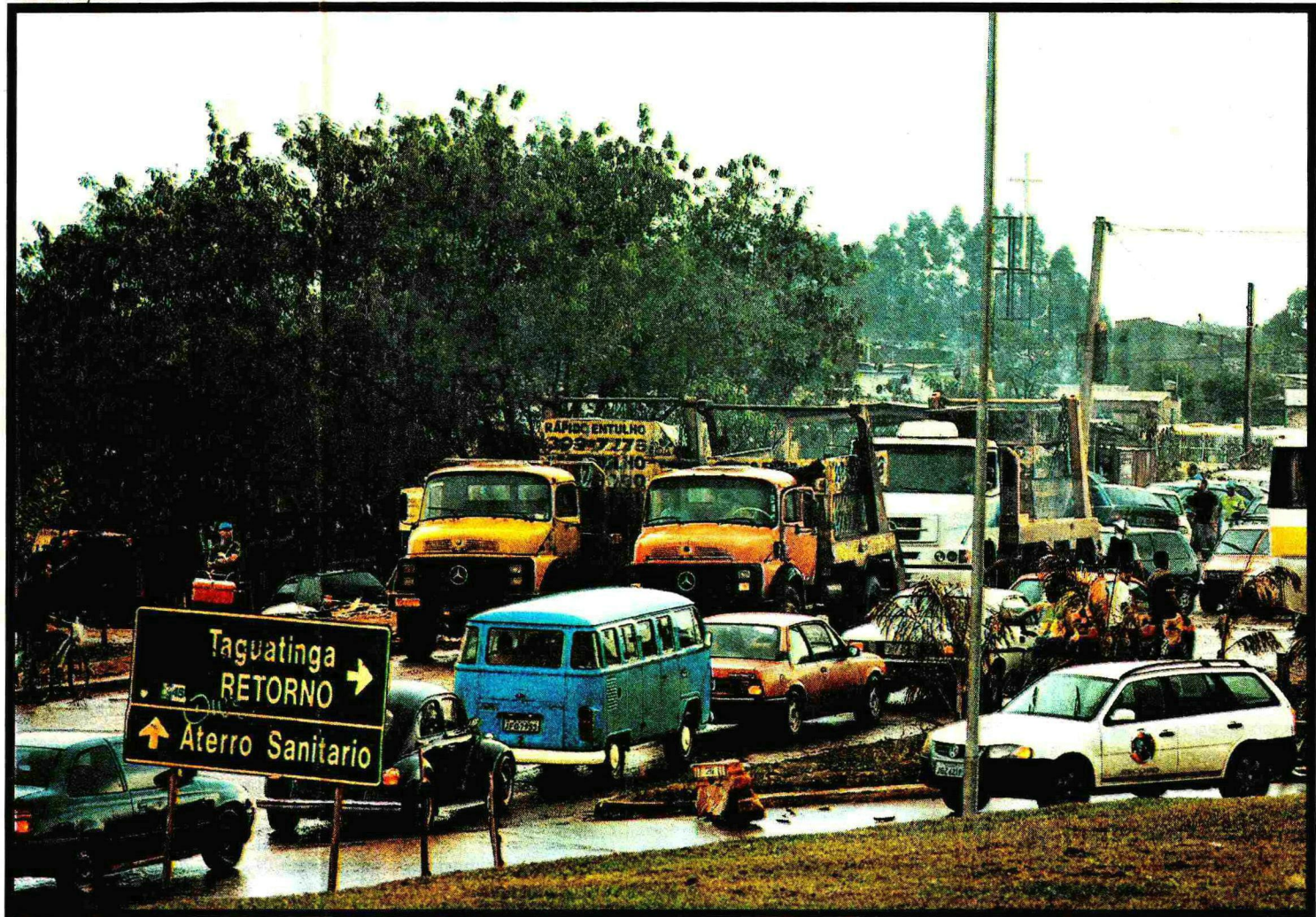
BUEIROS ENTUPIDOS DE VIADUTO NA ESTRUTURAL PROVOCARAM ALAGAMENTOS: TRÁFEGO LENTO DE VEÍCULOS NAS VIAS DE ACESSO À INVASÃO E REDONDEZAS
