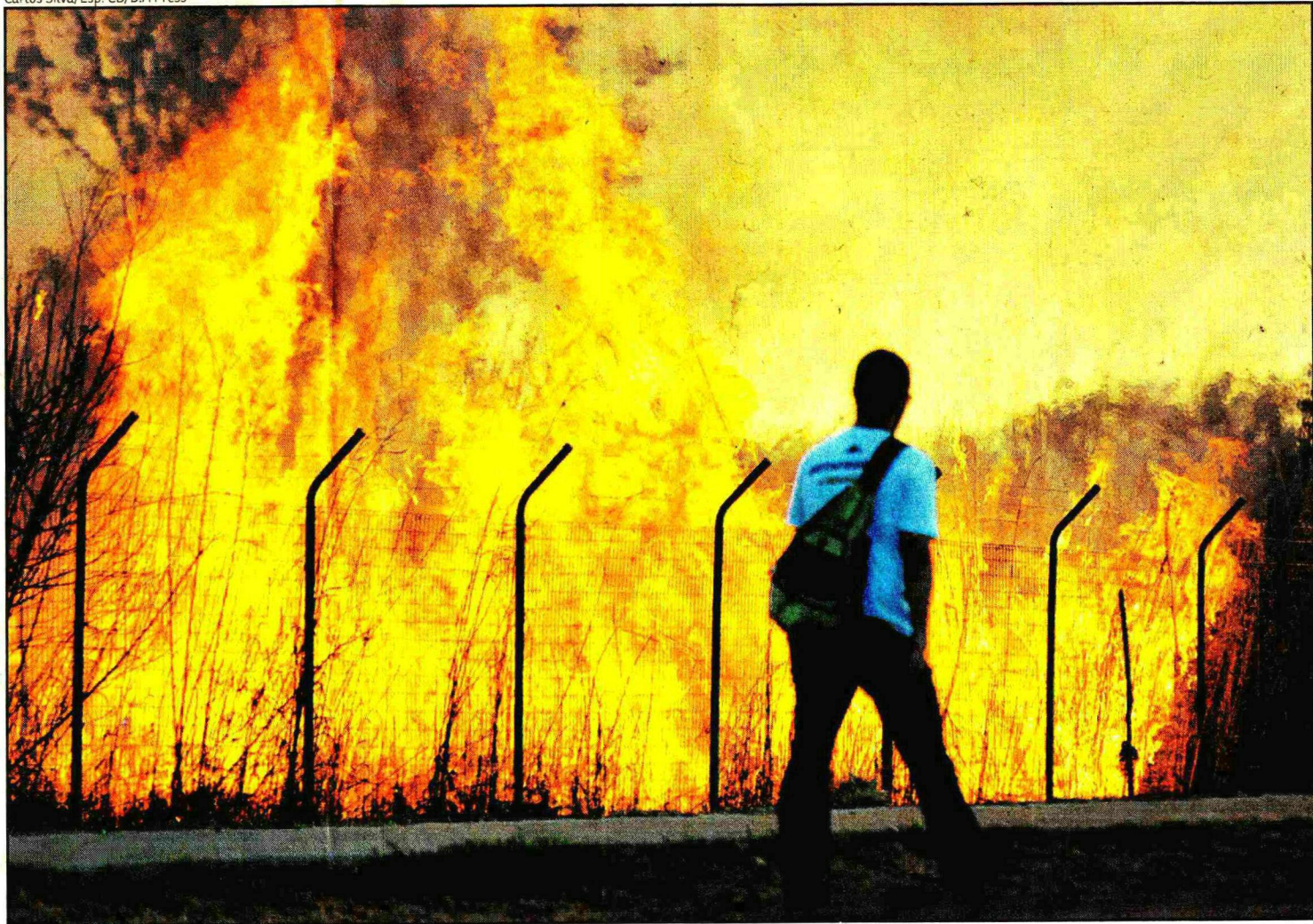
Nas proximidades da Residência Oficial do Torto, chamas de 10m de altura queimaram ontem à tarde as torres de uma linha de alta tensão
