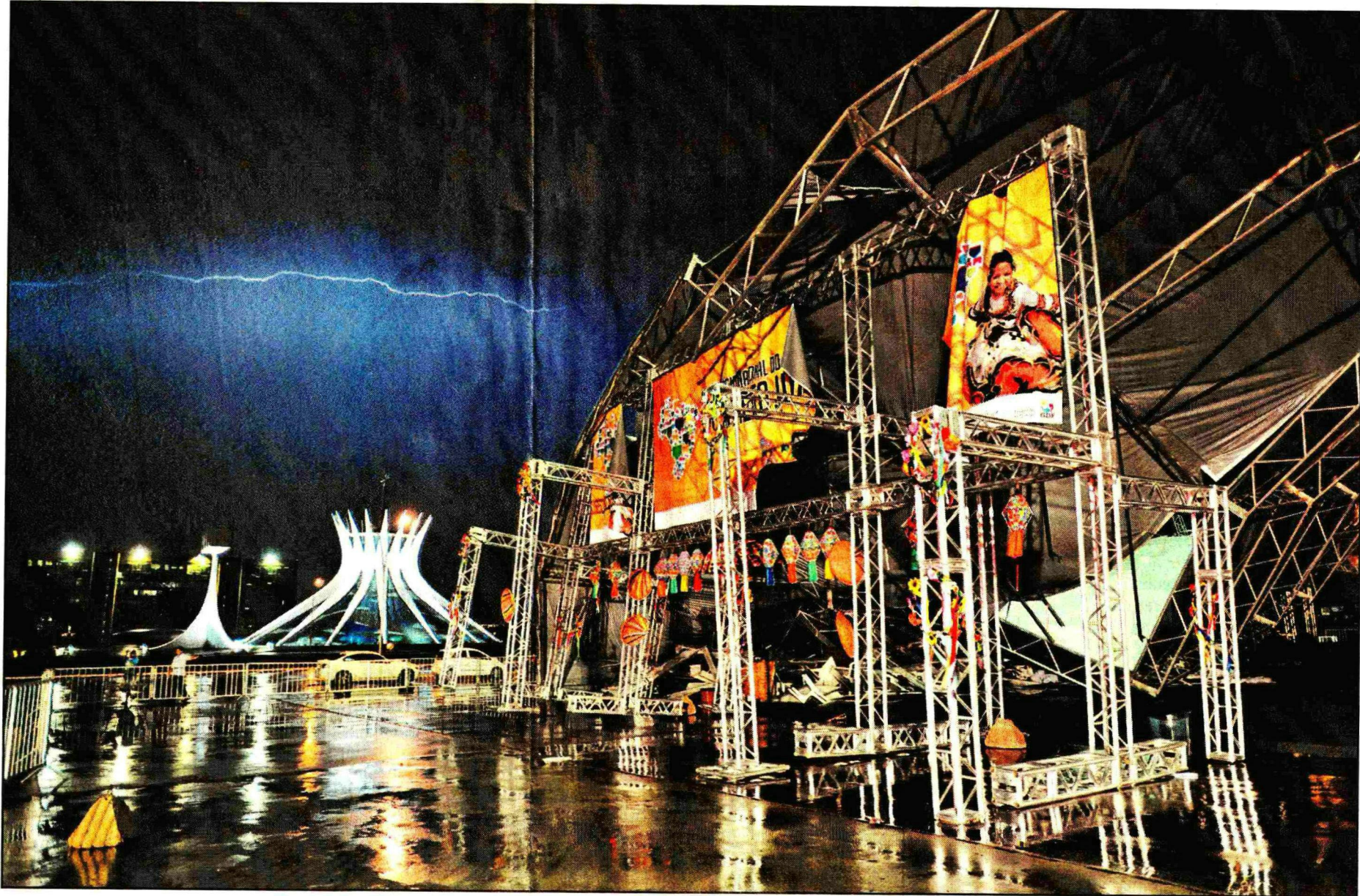
Raio visto na Esplanada dos Ministérios, onde, na noite da última quinta-feira, desabou uma estrutura metálica instalada em frente ao Museu Nacional: desespero durante o jantar
