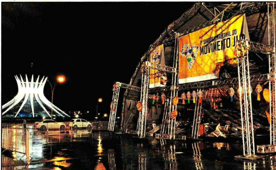
Tenda montada na Esplanada não resistiu à ventania: vítimas sofreram fraturas e arranhões
