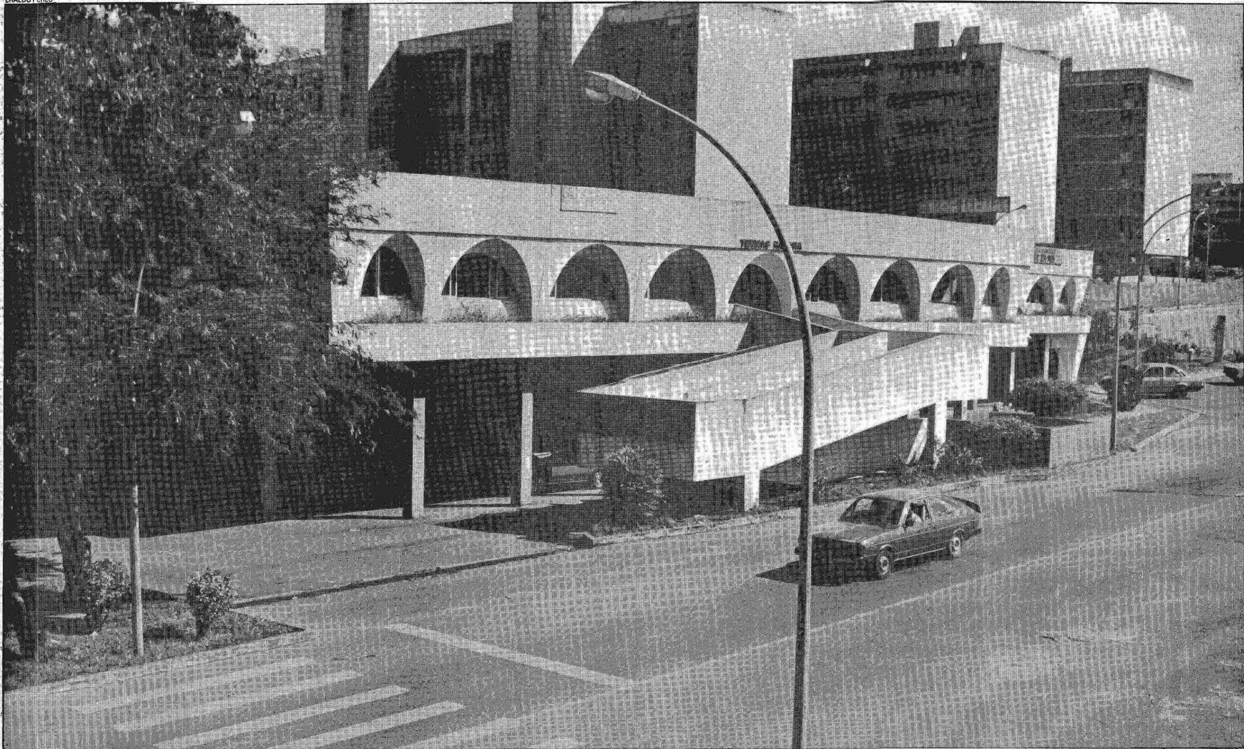
A quadra comercial da 205/6 Norte foi construída conforme o projeto original da cidade, com a fachada das lojas voltadas para os blocos residenciais. A idéia não deu certo
