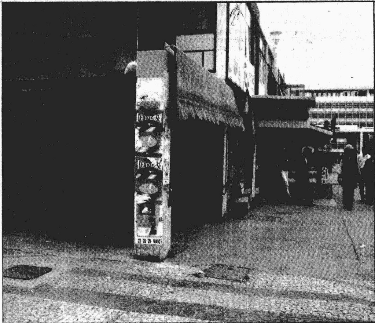
Local já nasceu marcado pelo abandono, com labirintos, desníveis e construções precárias
