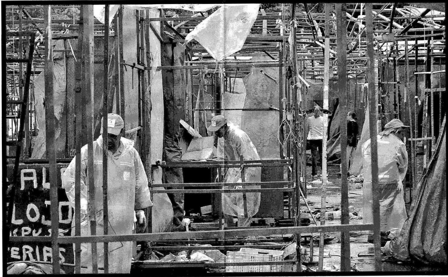
HOMENS DO SLU E DA NOVACAP DESMONTARAM AS ESTRUTURAS DAS BARRACAS E LIMPARAM A ÁREA DO GRAN CIRCO LAR ONTEM: ESPLANADA SEM CAMELÔS
