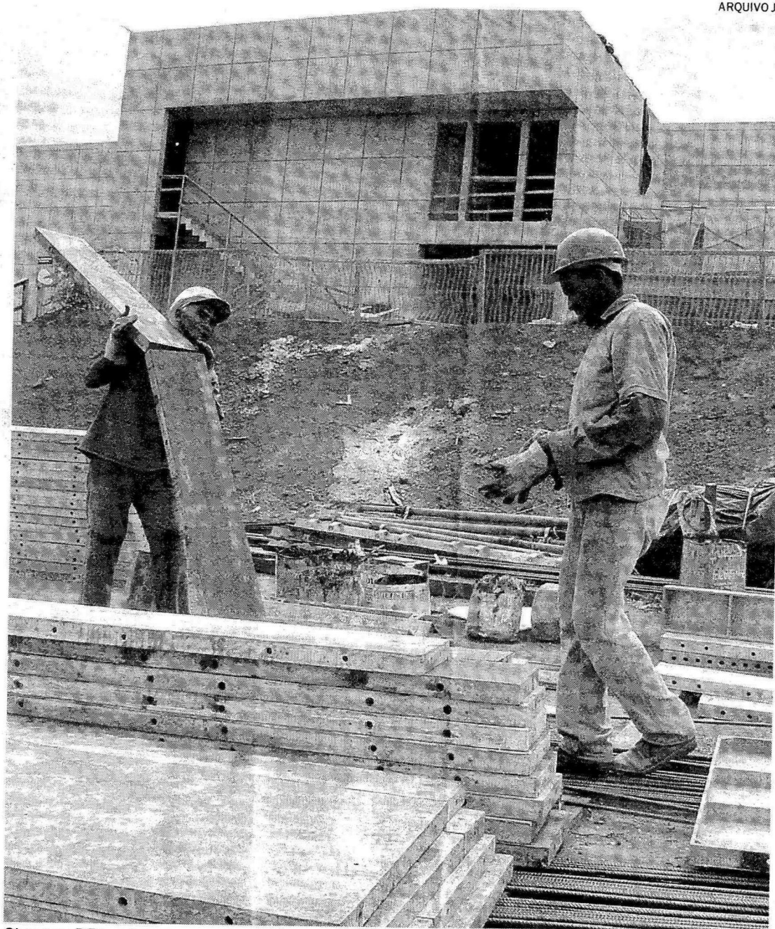
Obras no DF tendem a se reativar com maior facilidade para aquisição e retomada de investimentos
