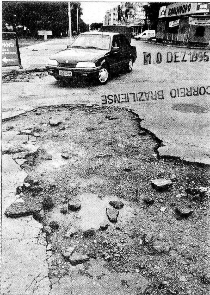
A chuva abriu um buraco de três metros na pista de acesso ao Ceub
