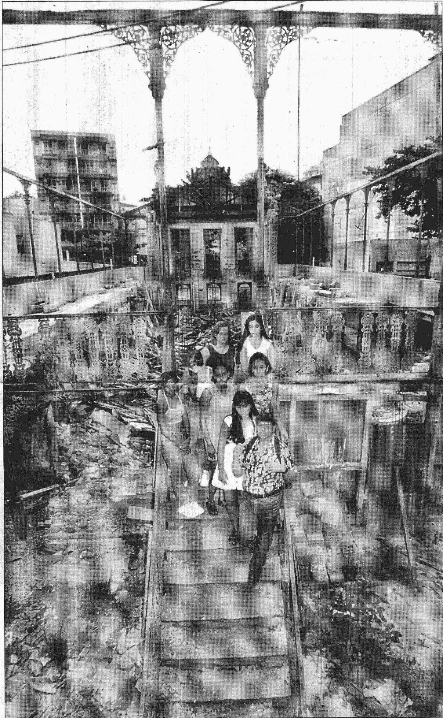
COLÉGIO CENTRAL do Brasil, no Méier: desde que o ano letivo começou, os alunos estão sem aulas porque a escola está em ruínas
