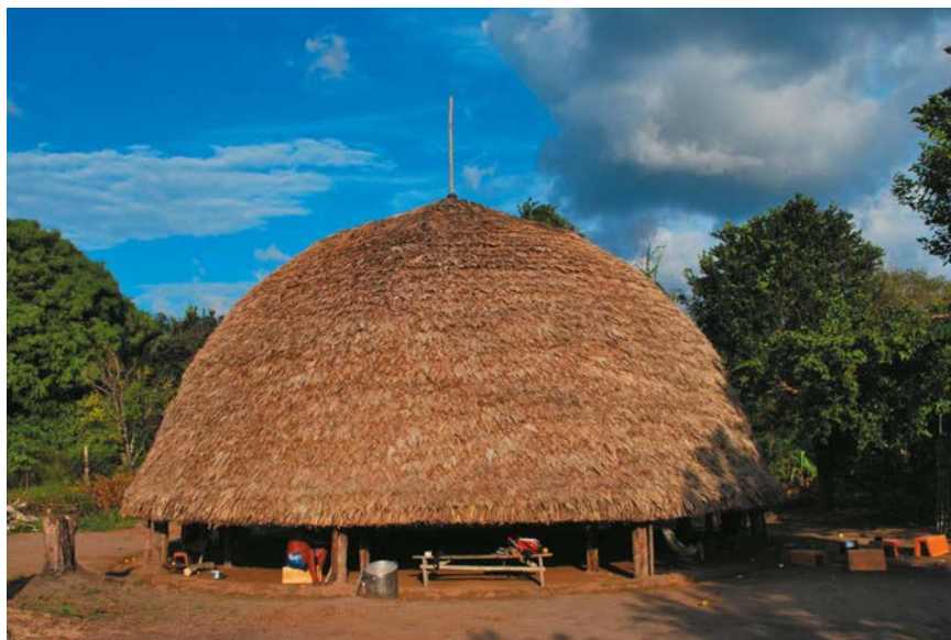
Figura 23 – Casa comunal tukusipan/porohtopo da aldeia Xuixuimene, Terra Indígena Rio Paru D'Este. Fonte: Do autor
