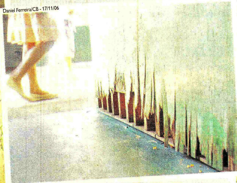
PAREDES RACHADAS FEITAS DE MADEIRA E OUTROS ESTRAGOS
