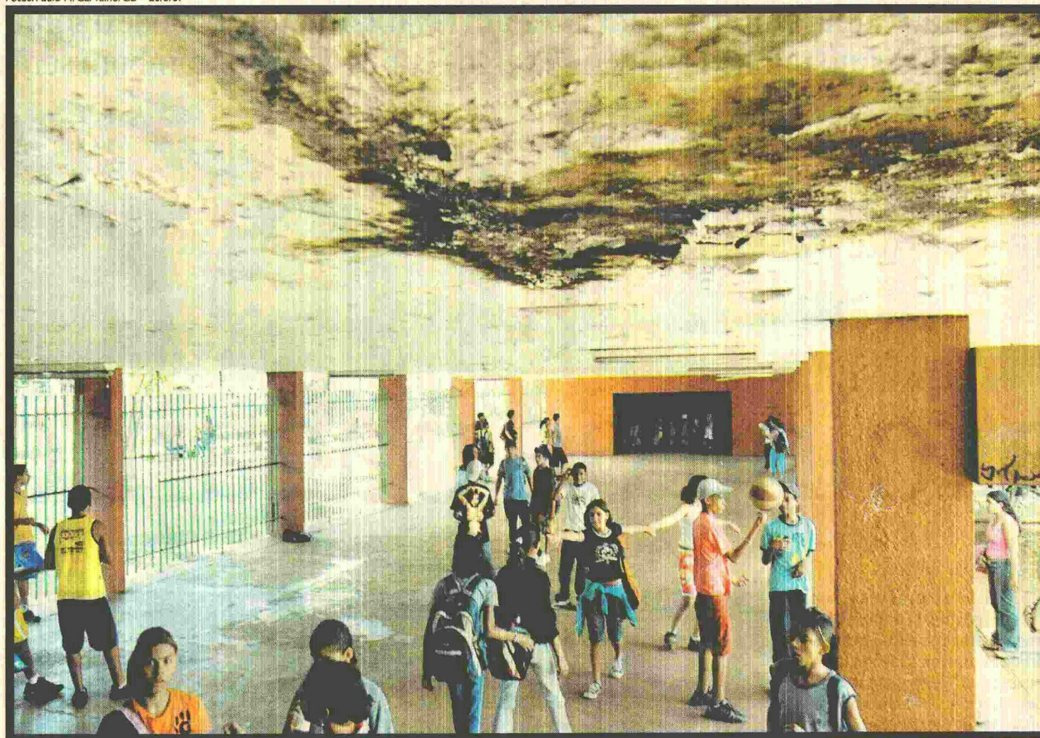
AS INFILTRAÇÕES TOMARAM O TETO DOS CORREDORES DO CASEB, NA 909 SUL, TRINCAS DESCEM PELAS PAREDES E O REBOCO DESABA: UMA DÉCADA À ESPERA DE REFORMA
