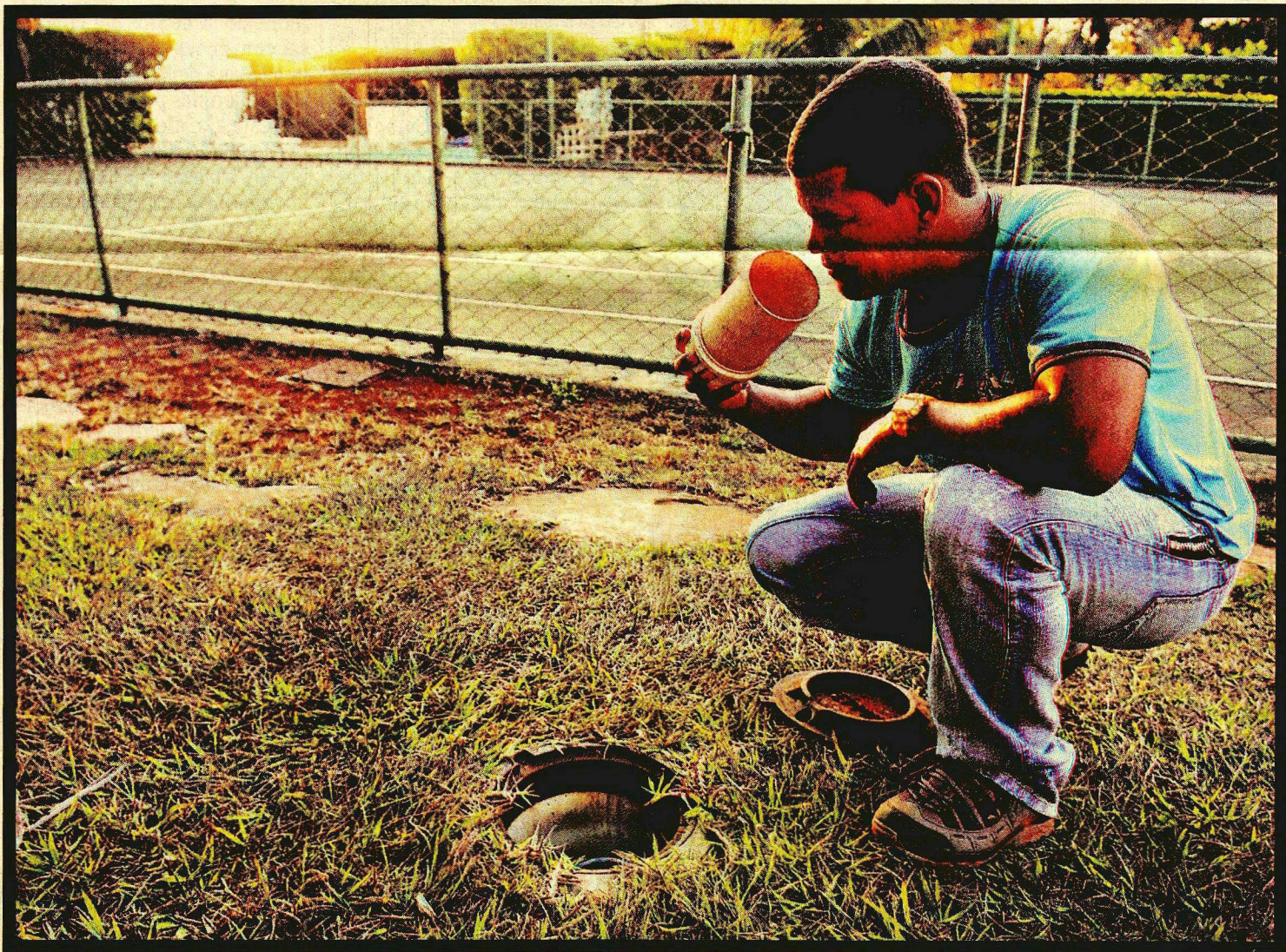
FUNCIONÁRIO DO BISPO RODOVALHO EXAMINA "SUSPIRO" INSTALADO PELA PETROBRAS PARA SAÍDA DE GASES E ANÁLISE DE CONTAMINAÇÃO
