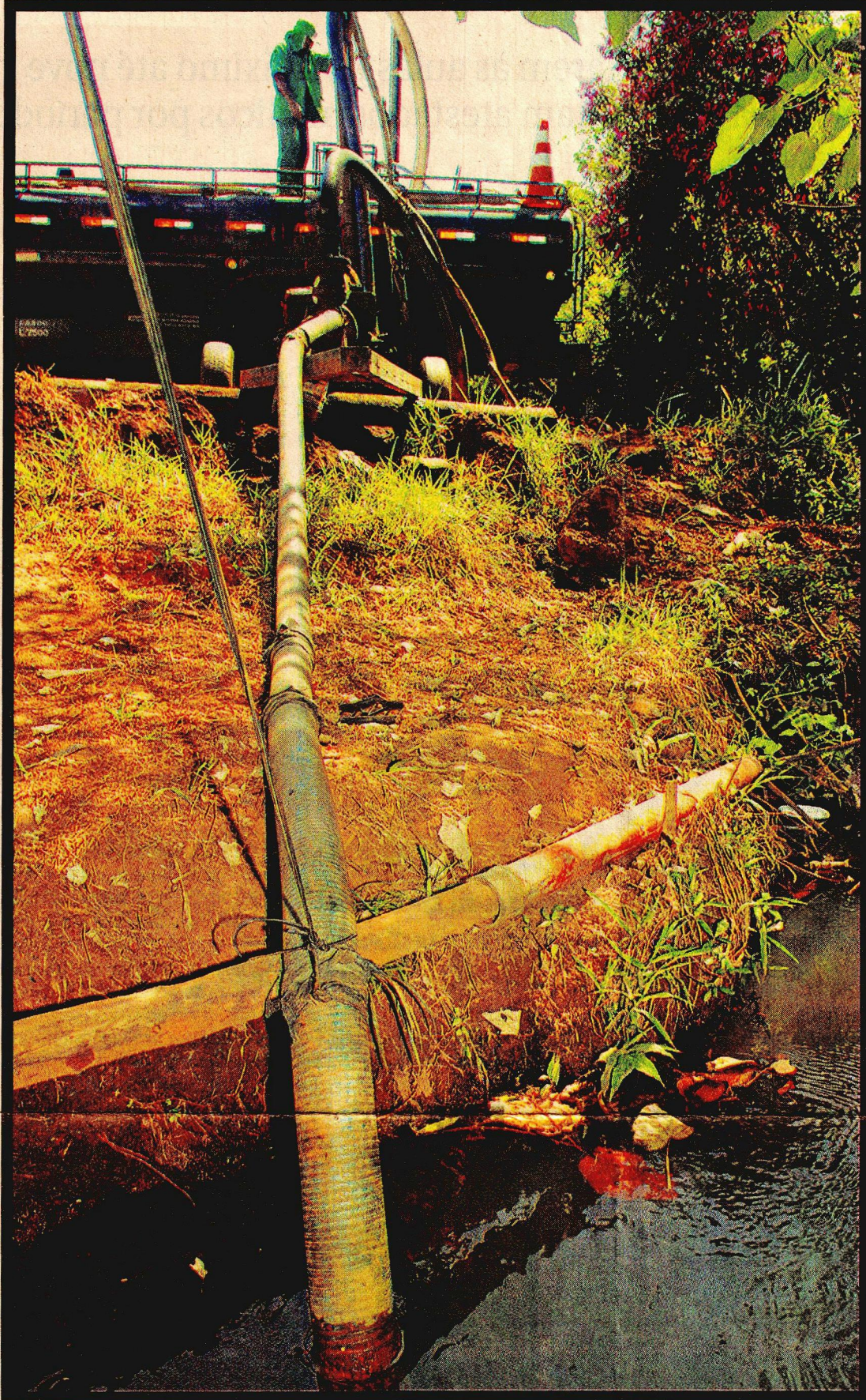
DRAGA INSTALADA NO CÓRREGO: 10 MIL LITROS DE ÁGUA PUXADOS DO LEITO EM APENAS SETE MINUTOS
