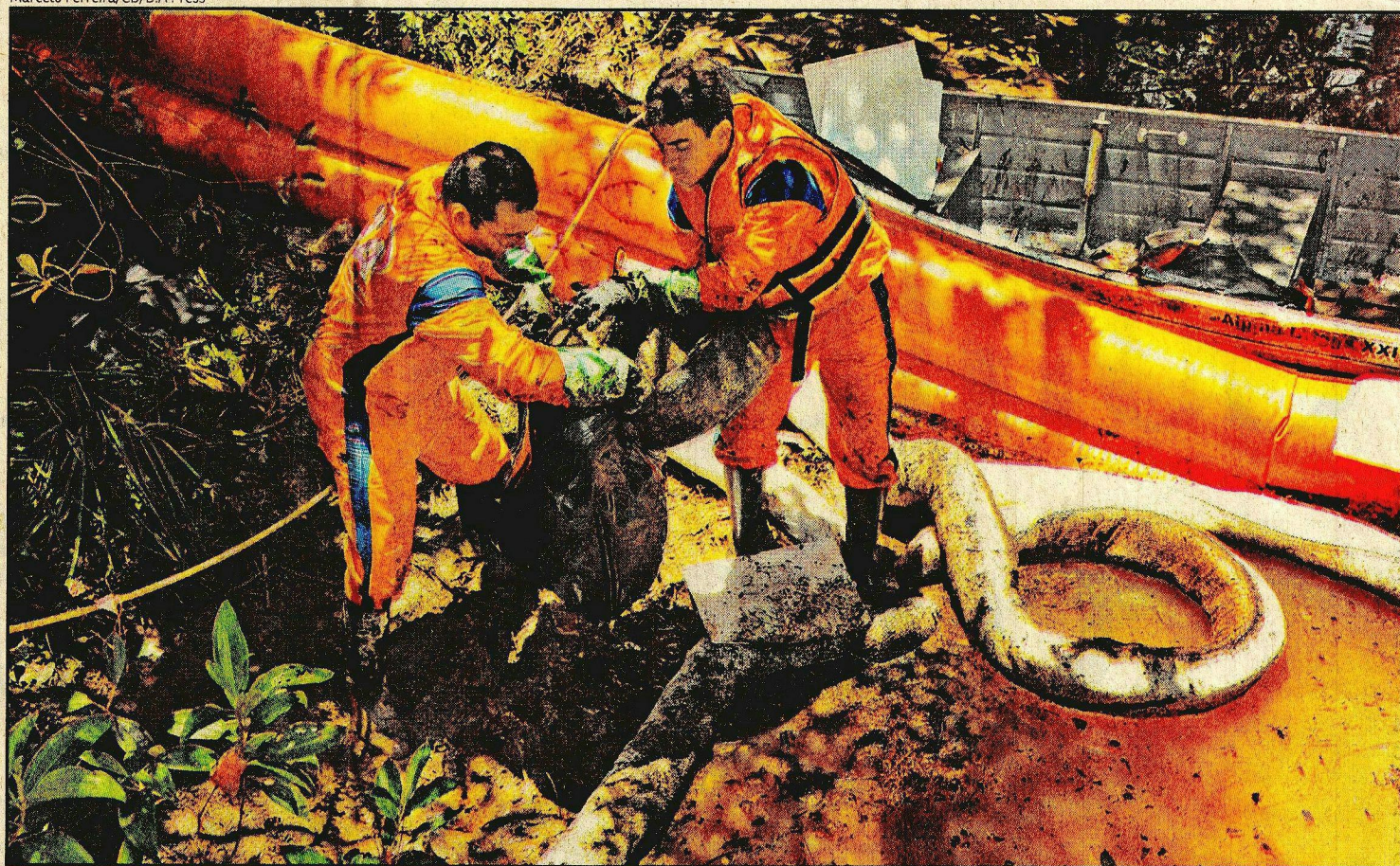
Homens trabalham na retirada de óleo do Córrego Engenho das Lajes: mantas de contenção ficaram encharcadas com o produto
