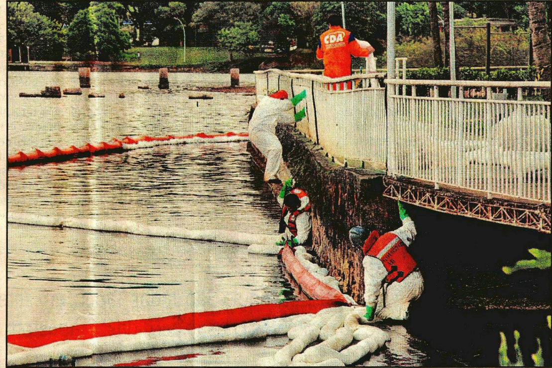
Funcionários da Petrobras trocam e monitoram as boias de contenção instaladas no late Clube
