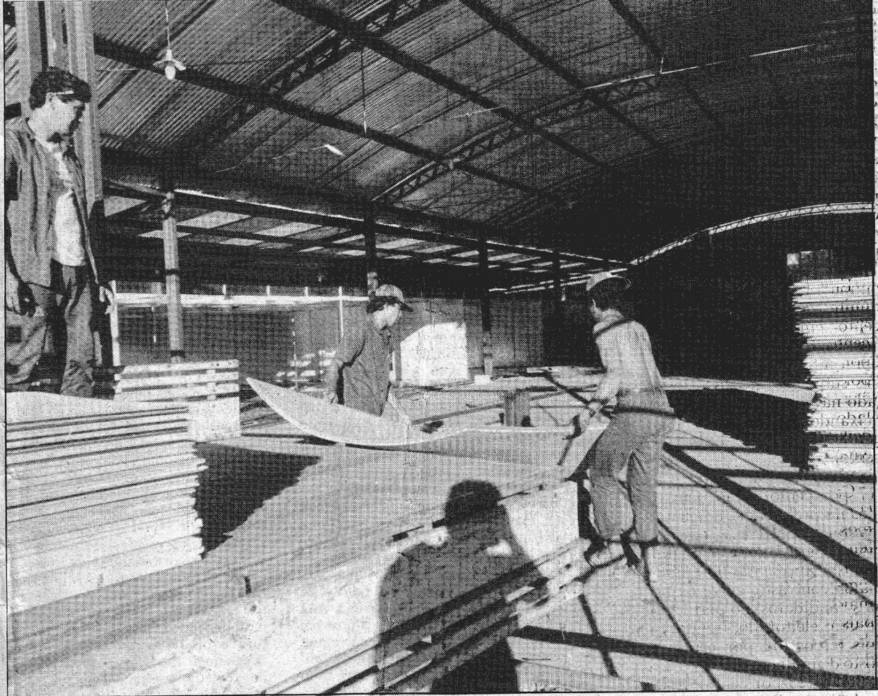
Rezek quer inaugurar a central de apuração, no Centro de Convenções, até o dia 10. São 57 mil metros quadrados
