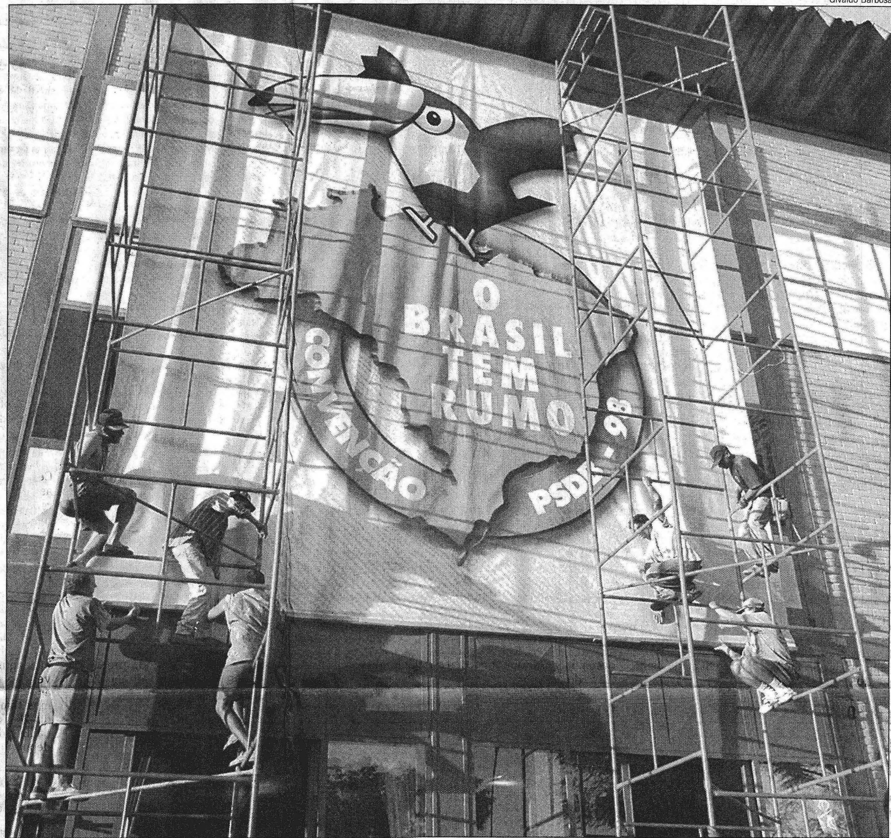
OPERÁRIOS DÃO os últimos retoques na fachada da Escola de Música, onde será realizada hoje a convenção do PSDB que lançará a candidatura de Fernando Henrique
