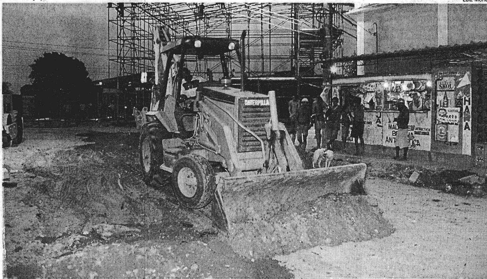
Asfaltamento da Rua Moquetá já estava previsto, mas segundo engenheiro responsável foi antecipado em razão da visita de Fernando Henrique
