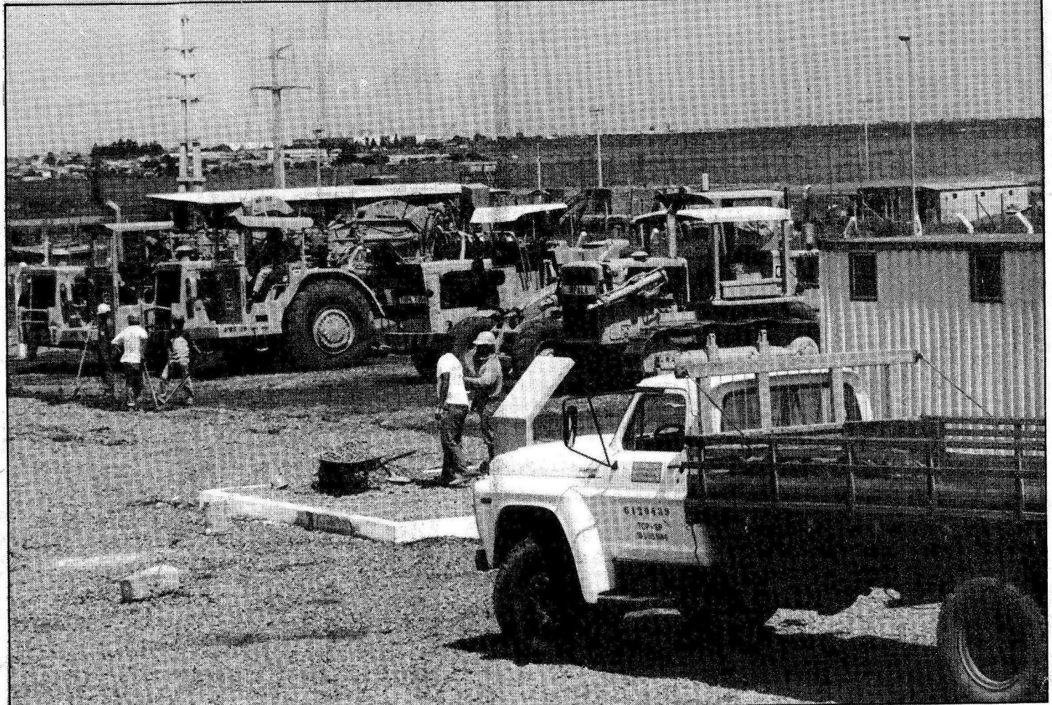
Máquinas e operários já estão de prontidão no canteiro de obras em Samambaia, onde será lançada hoje a pedra fundamental
