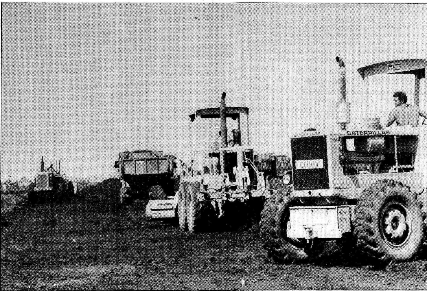
Os operários não esperaram sequer a saída de Roriz e demais autoridades do local para iniciarem a operação de limpeza do terreno
