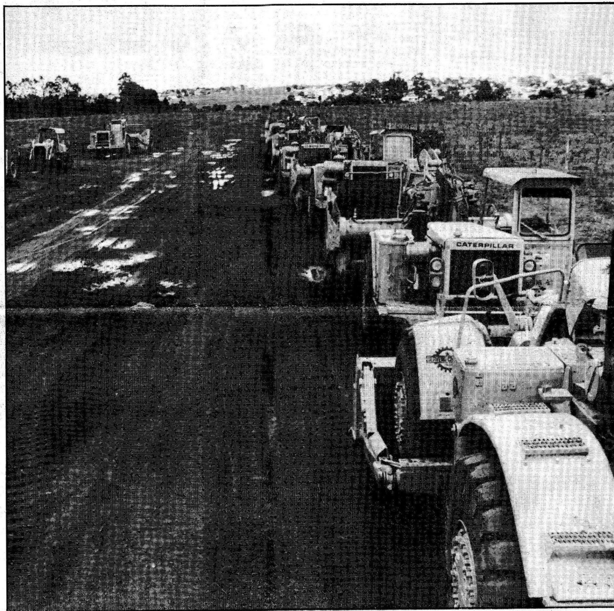
Os trabalhos de terraplenagem do trecho Águas Claras a Samambaia estão quase prontos
