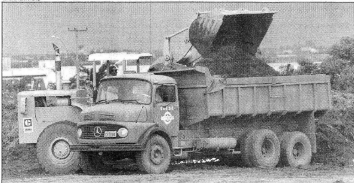
Máquinas e caminhões iniciaram o serviço de terraplanagem do futuro Complexo de Manutenção
