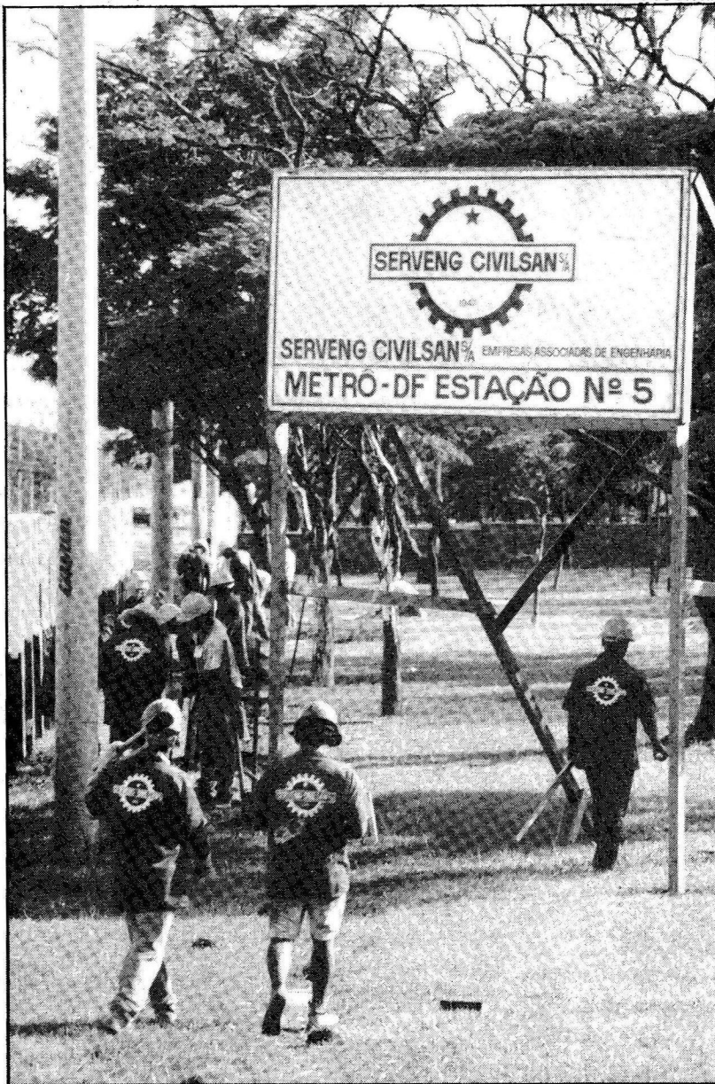
Os tapumes estão sendo instalados ao longo do Eixinho Oeste
