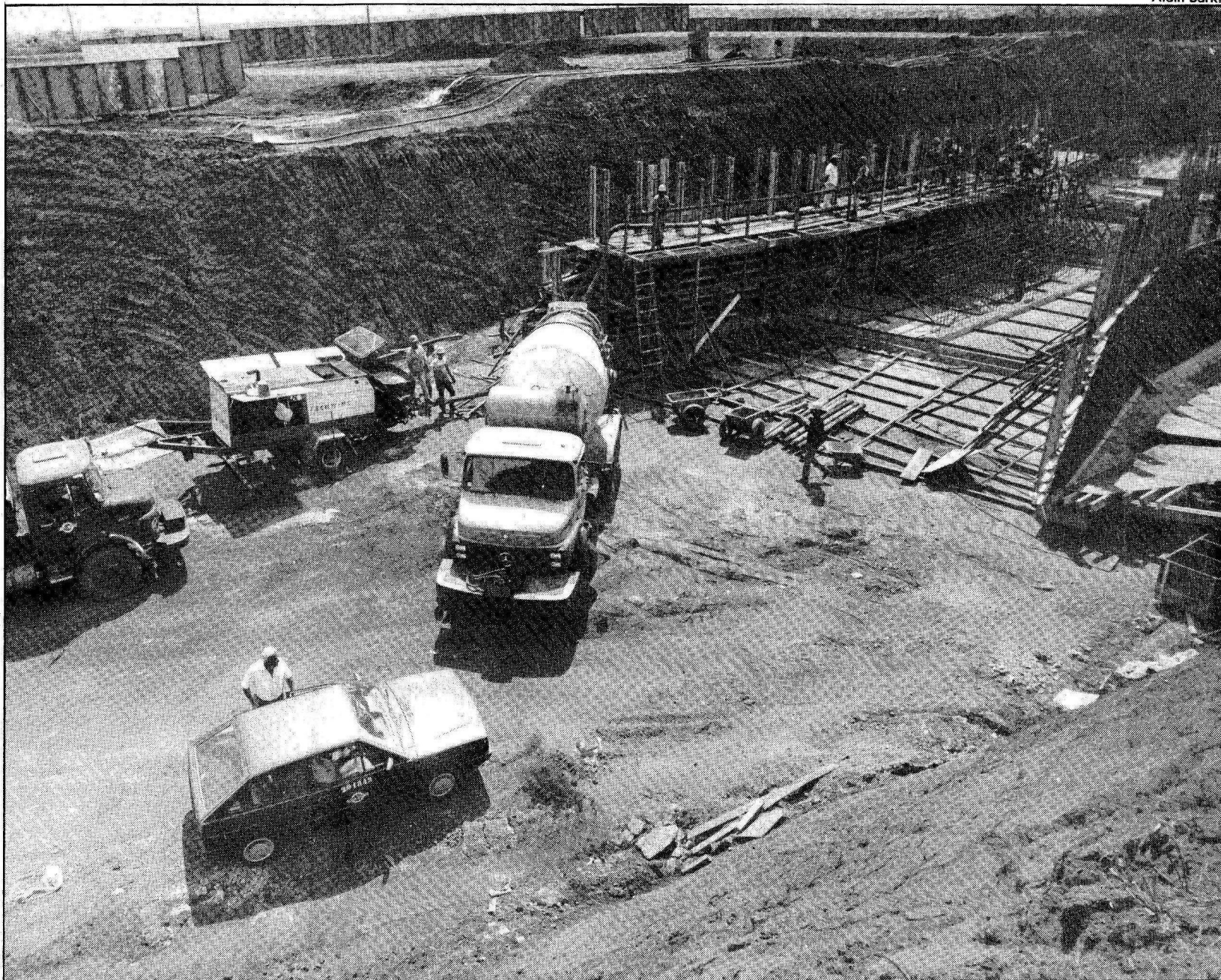
Além do viaduto de Ceilândia, as obras do Metrô em Samambaia também estão avançadas dois meses em relação ao cronograma
