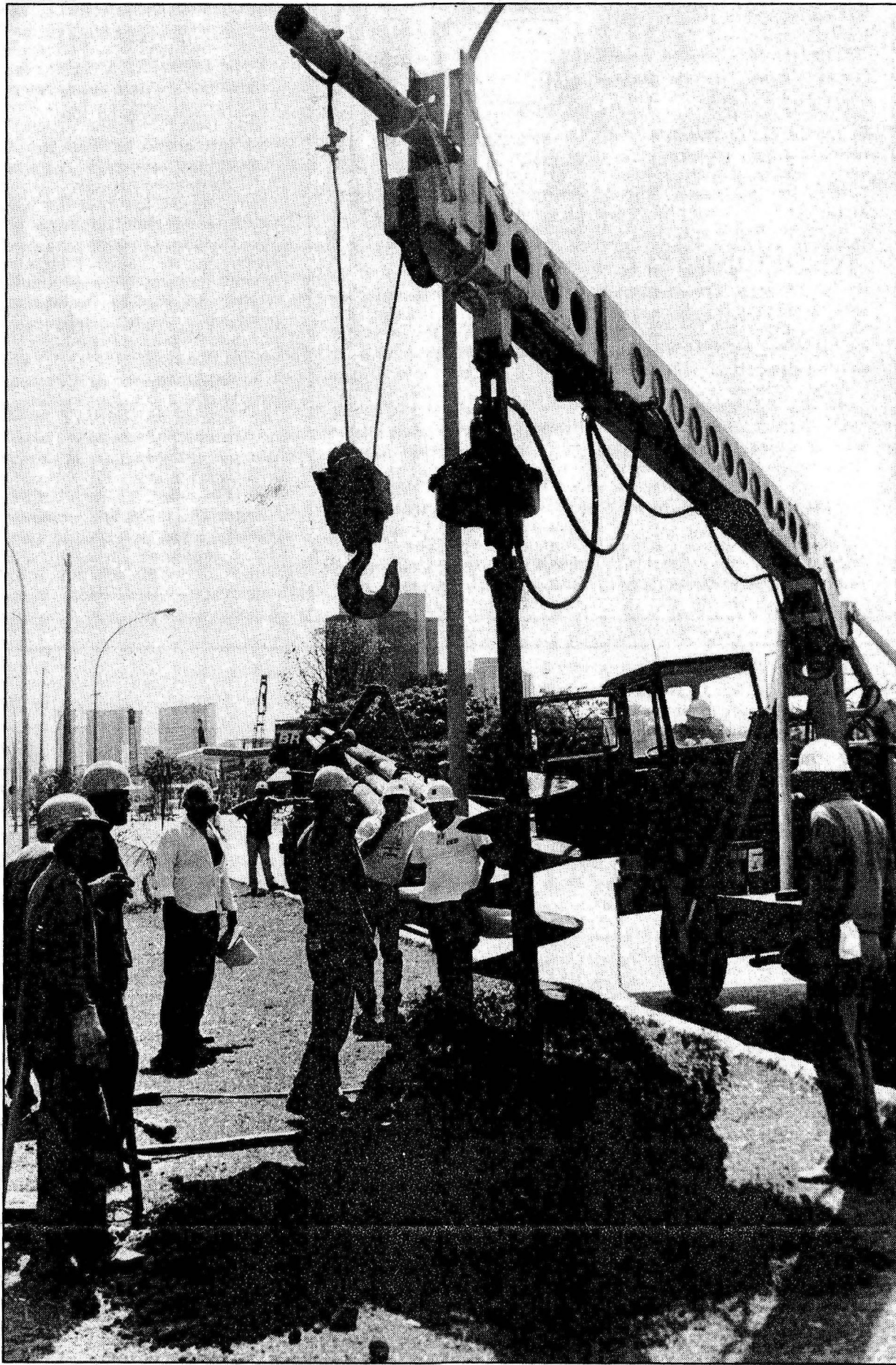
A instalação de postes para rede de energia bloqueou parcialmente, ontem, o Eixinho W-3 Sul das 6h às 20h
