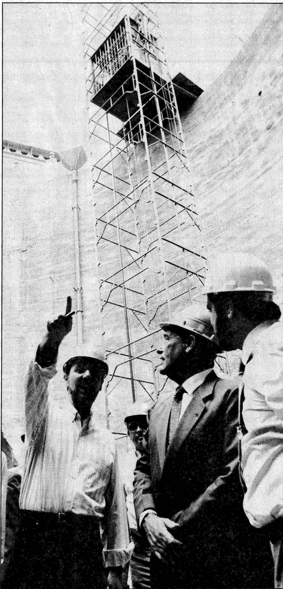
Arruda mostra ao governador as vantagens das técnicas de engenharia usadas na obra
