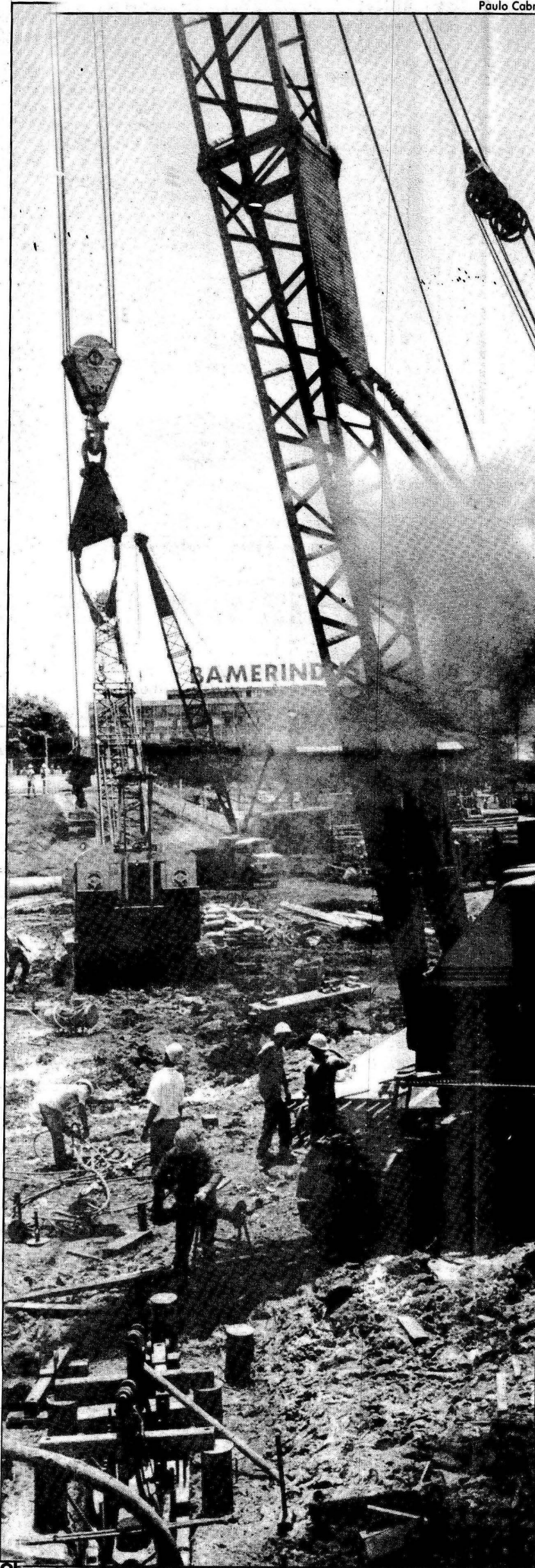
Obras do metrô devem proporcionar empregos para seis mil
