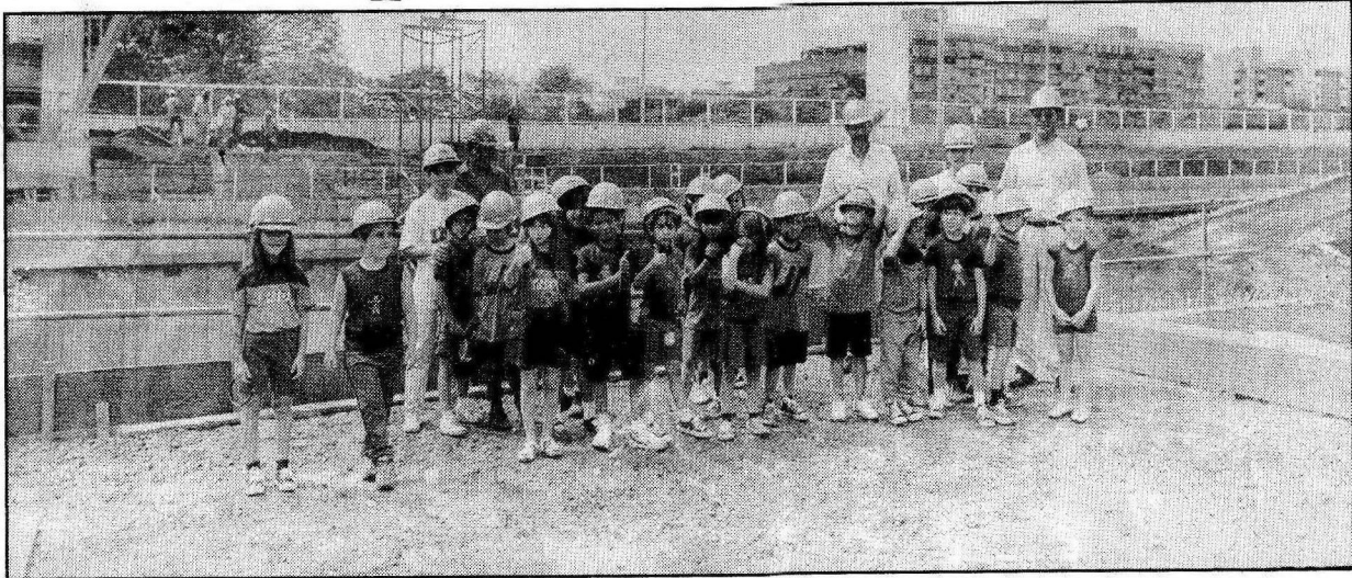
Os estudantes visitaram as obras no Eixo Sul e receberam informações sobre a construção do metrô
