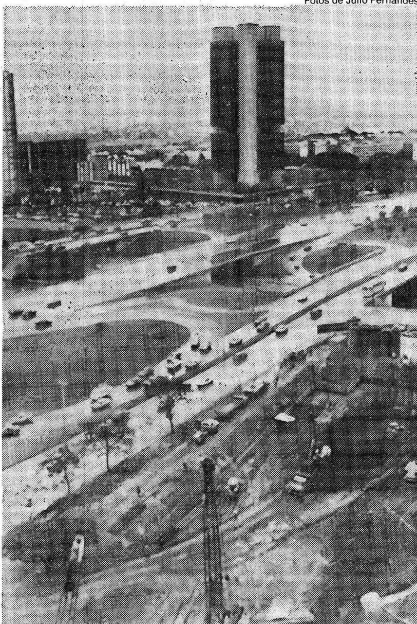
As obras do Metrô avançam e mudam os hábitos dos moradores
