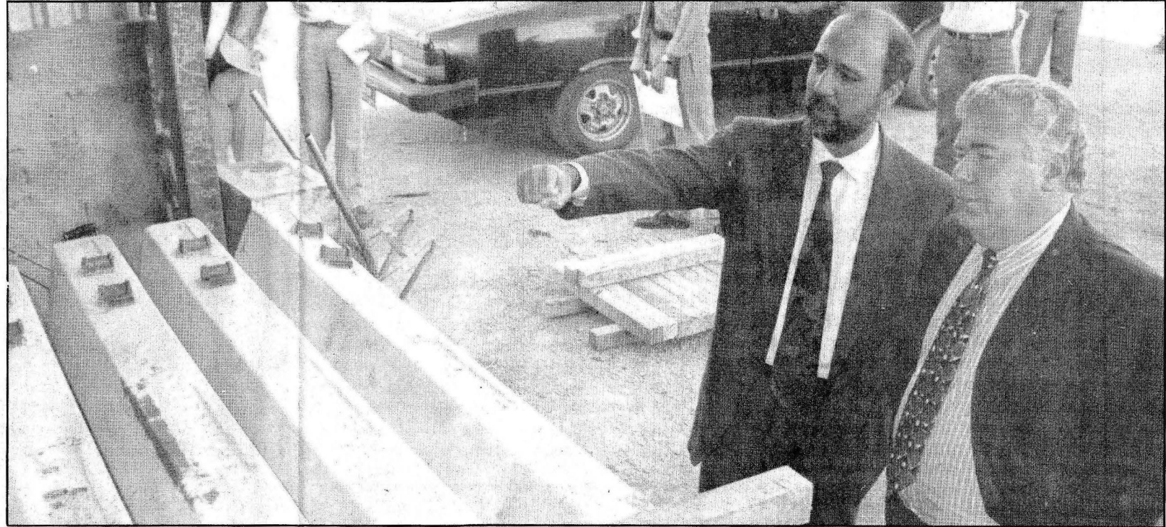
O ex-prefeito de Curitiba, Jaime Lerner, acompanhado do secretário de Obras, José Roberto Arruda, visita o canteiro de obras
