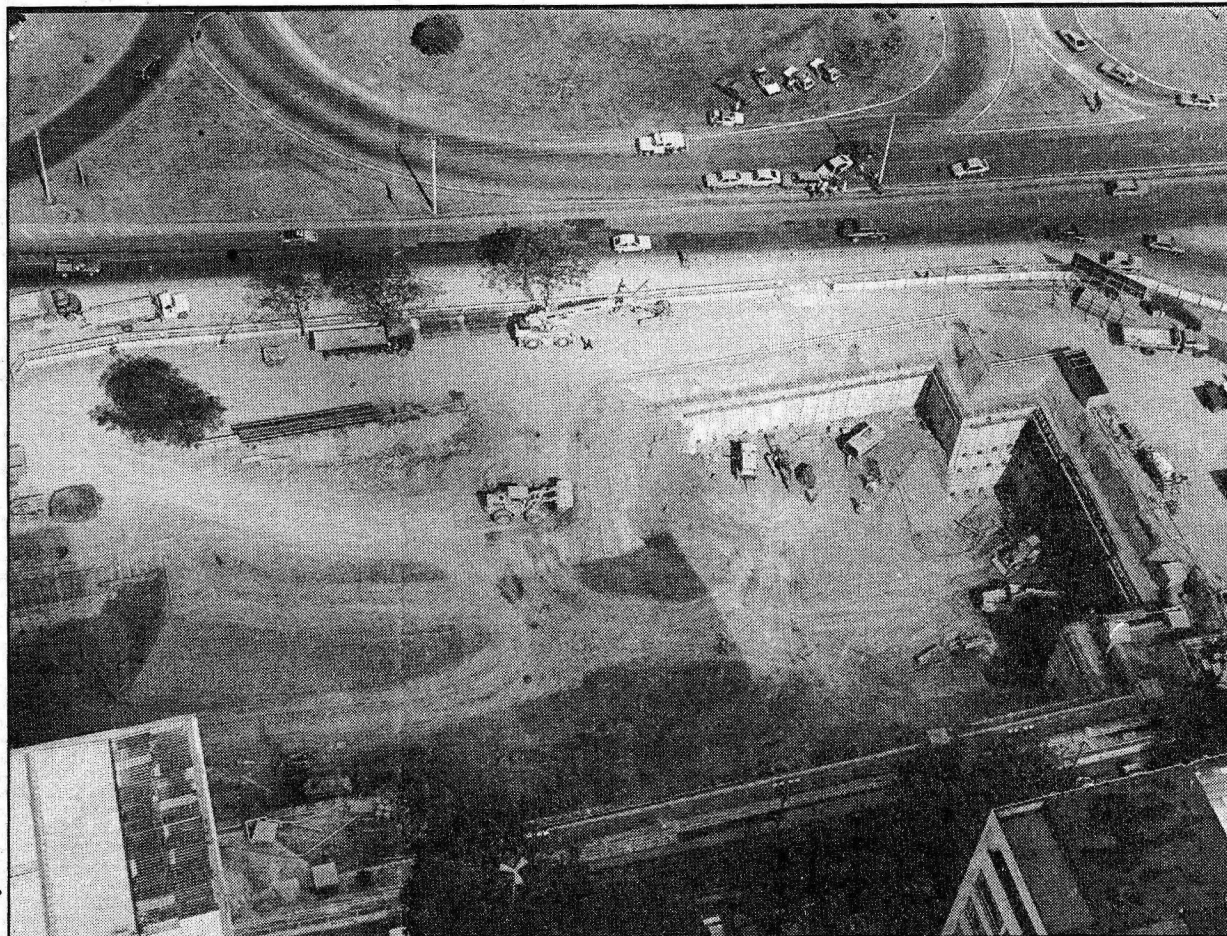
Pelo menos 700 metros de túneis são construídos a cada mês nas 14 frentes de trabalho do Plano
