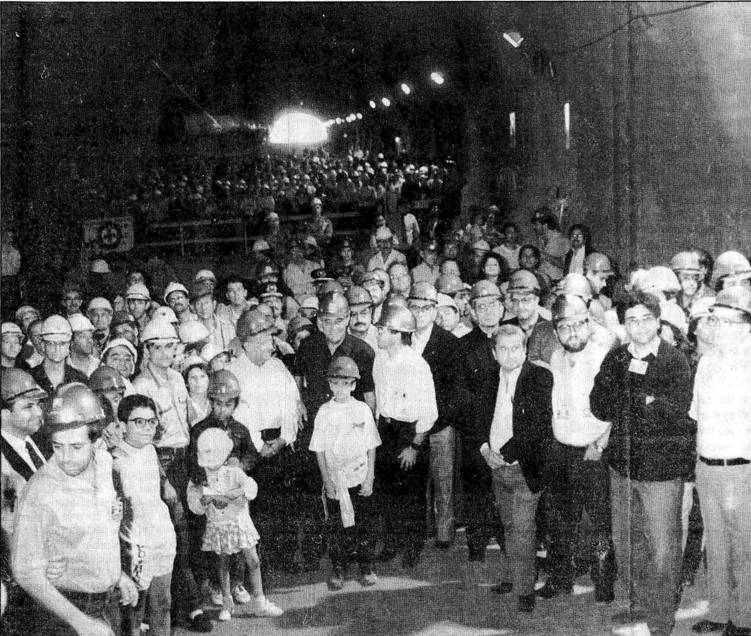
O governador, cercado por auxiliares, operários e populares, percorreu emocionado os 667 metros do túnel do metrô
