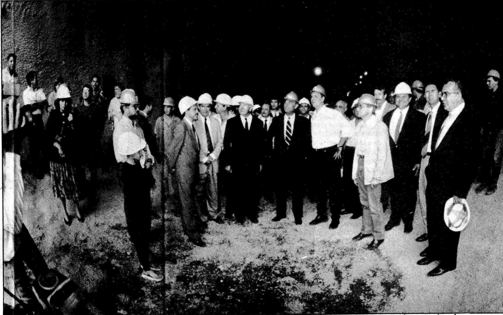
O encontro de túneis inaugurado pelo governador está sob um lençol freático que poderia comprometer o andamento das obras
