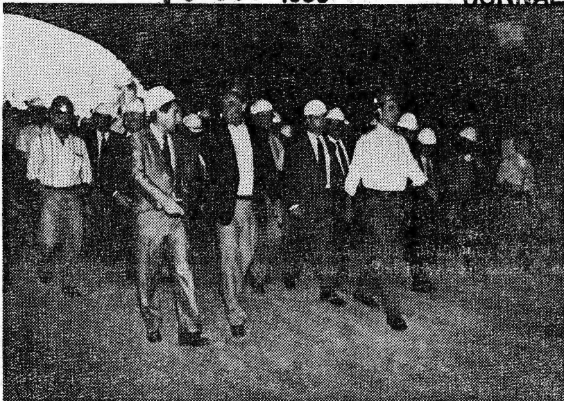
Roriz visitou o novo túnel e disse que o metrô será inaugurado em abril
