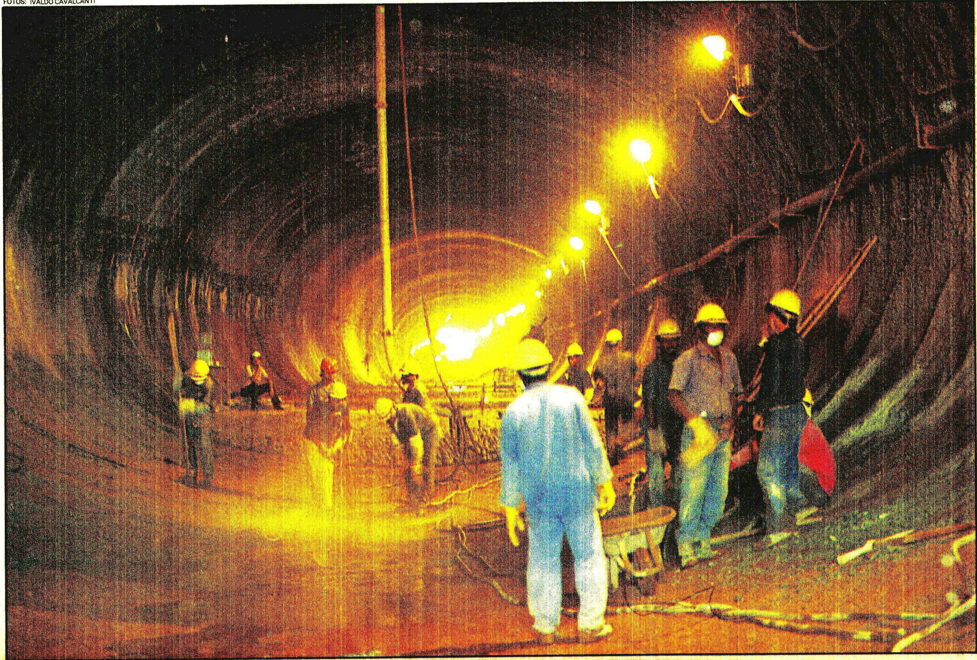
Os túneis subterrâneos por onde passarão os carros do metrô no Plano Piloto já estão em fase de concretagem e a previsão é de que sejam entregues no final do ano
