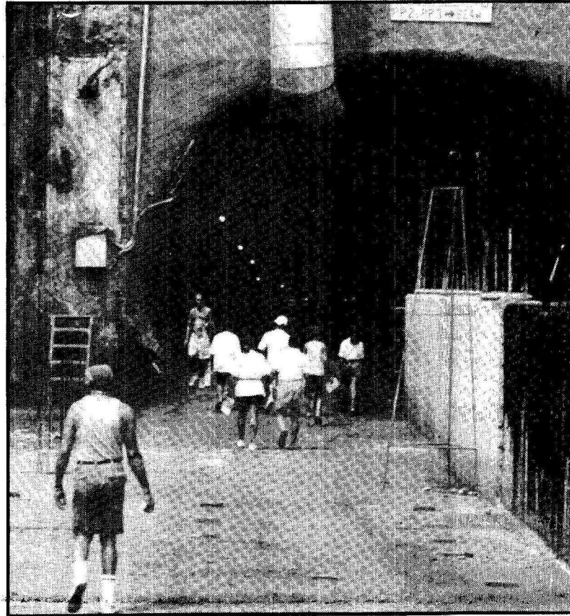
Até o fim do ano, os túneis da Asa Sul estarão concluídos
