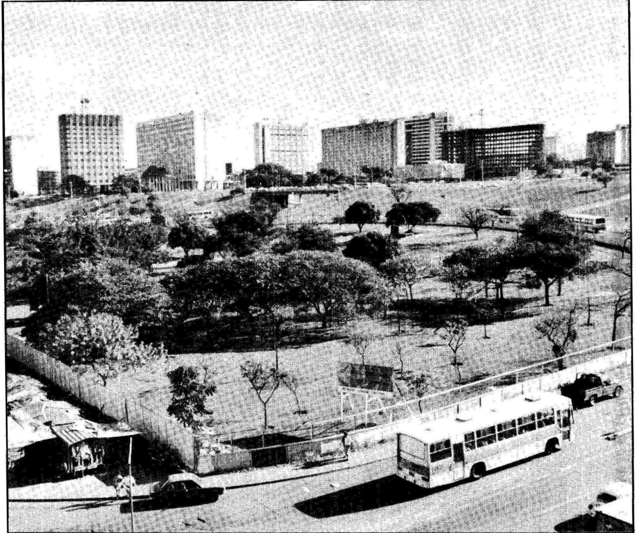
A estação subterrânea será construída ao lado da rodoviária do Plano Piloto
