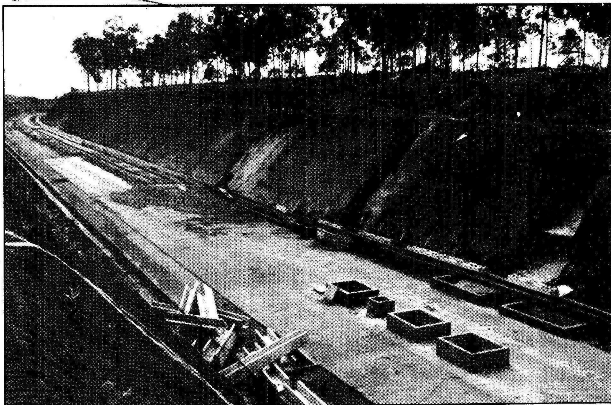
As obras estão expostas ao tempo e a erosão ameaça destruir parte do que foi concluído
