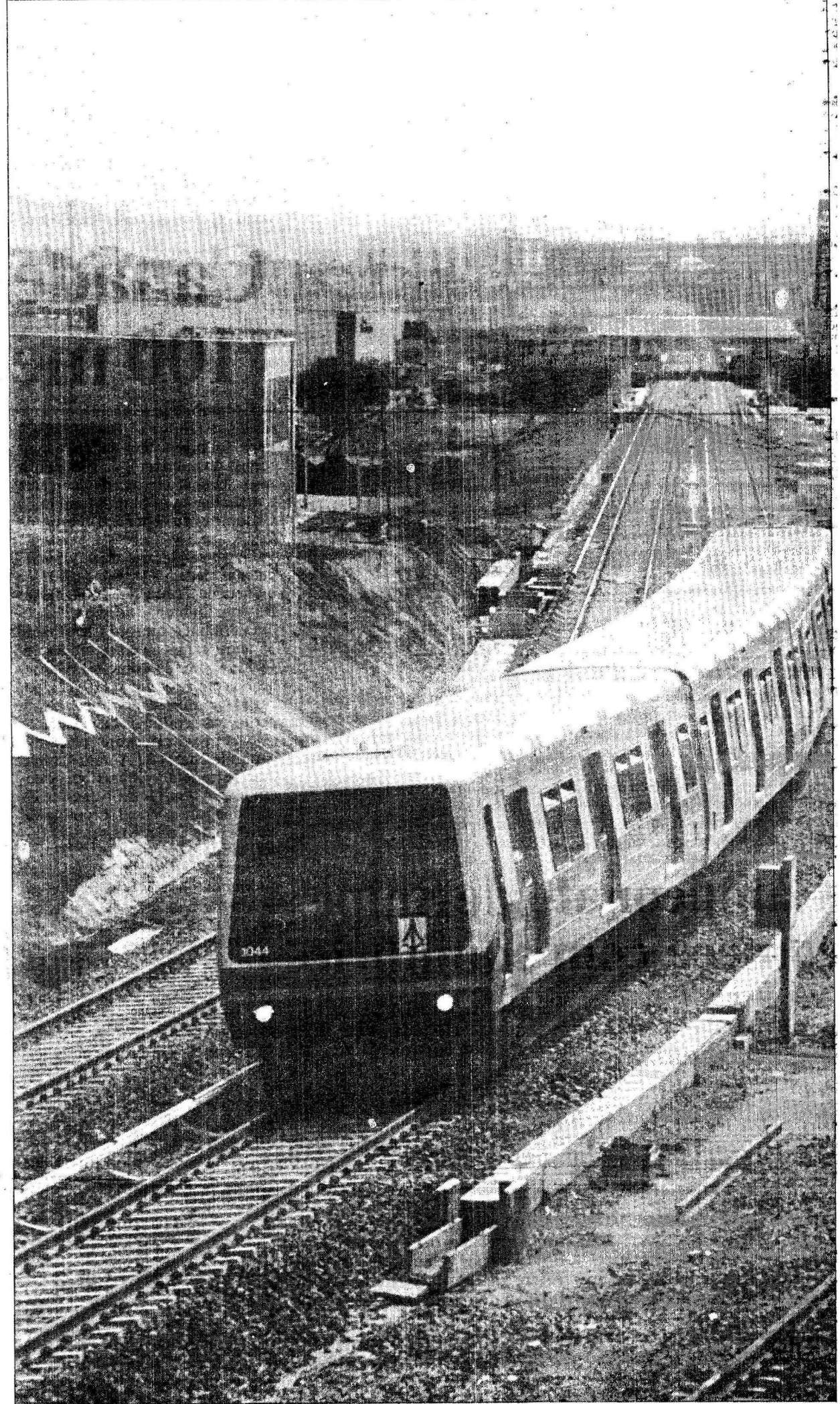
Para concluir as obras, como a estação do metrô no ParkShopping, o governo precisa de cerca de R$ 350 milhões
