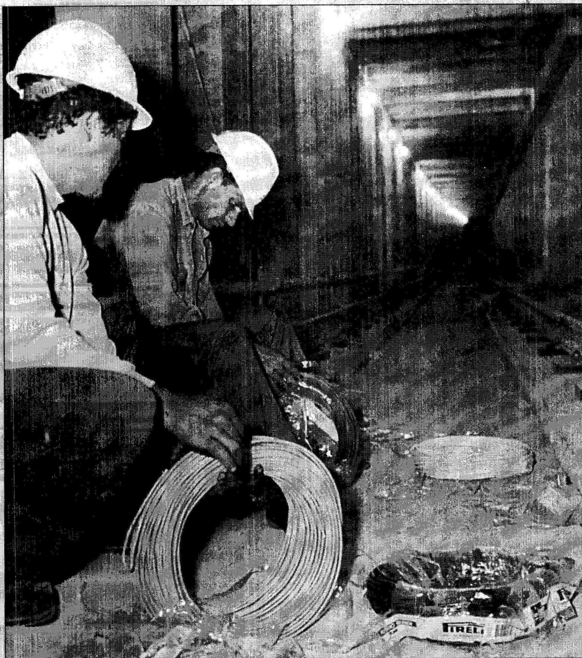
Operários começam a recuperar trecho dos trilhos no subterrâneo da Praça do Relógio, em Taguatinga
