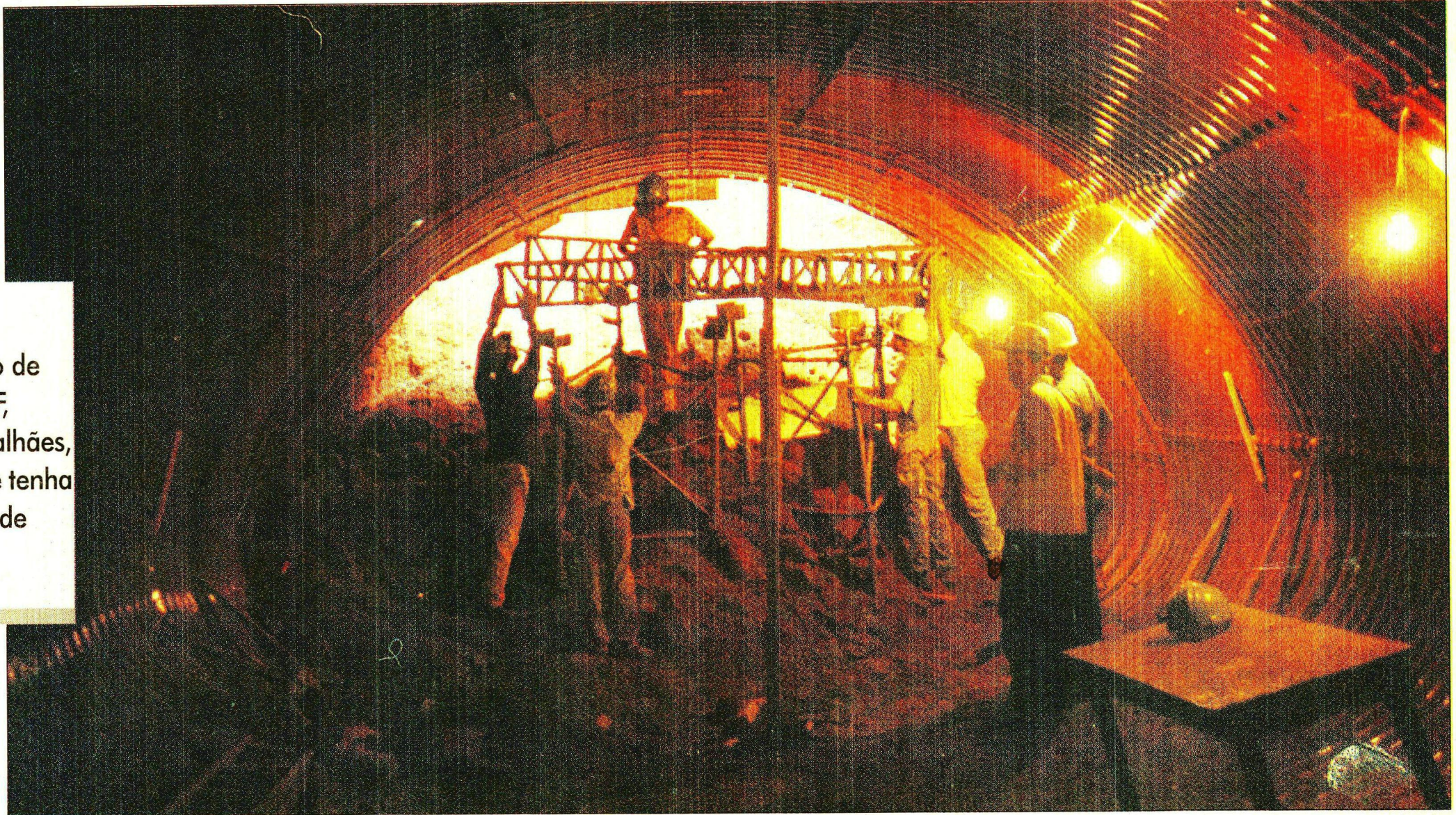
Operários do Consórcio Brasmetrô trabalham nas obras de reforço do sistema, corrigindo falhas nos túneis, em três pontes e num viaduto por onde passam algumas linhas do metrô
