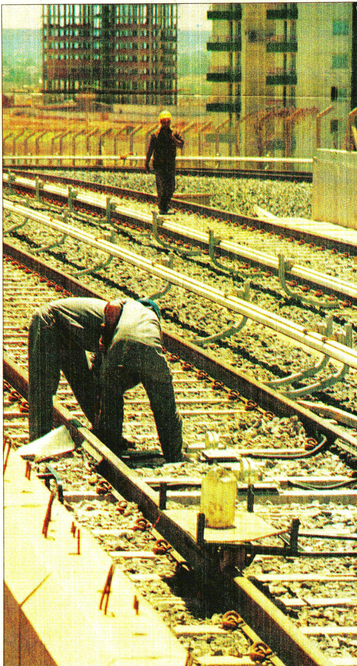
Operários trabalham nos trilhos que ligam o trecho Samambaia/ParkShopping, uma das primeiras linhas a funcionar
