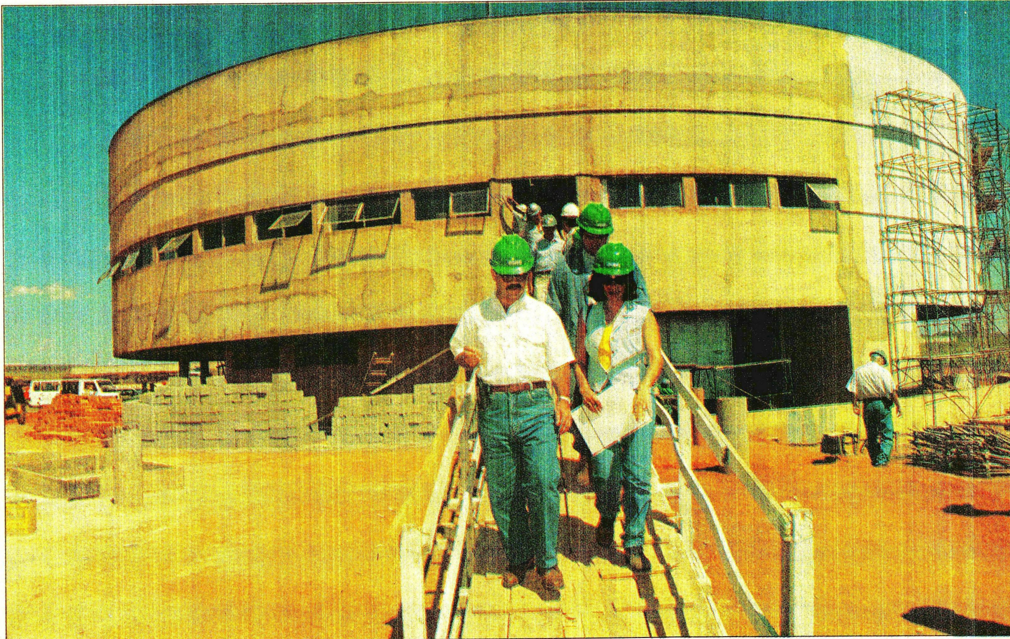
Centro de Controle de Sistema, que vai monitorar todas operações por meio de computadores, teve suas obras retomadas a partir de maio, quando o BNDES liberou recursos para o GDF
