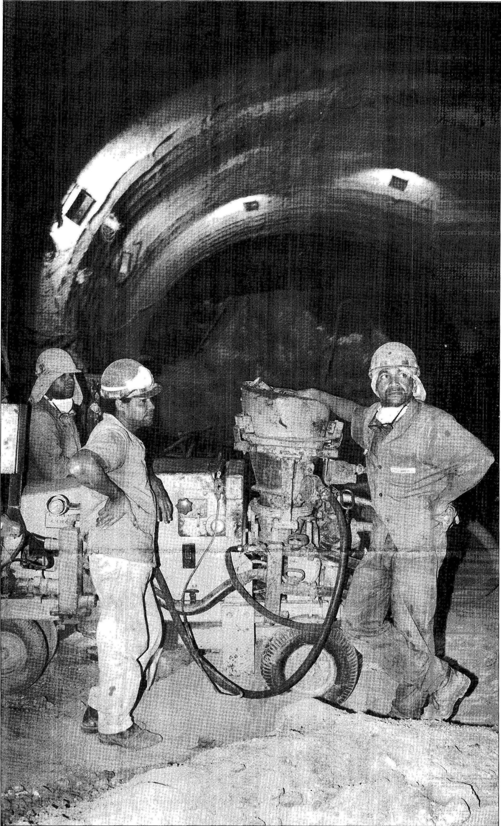
Operários trabalham no túnel de 300 metros, a ser entregue em maio de 98, que servirá para manobra dos trens entre a rodoviária e o Conjunto Nacional
