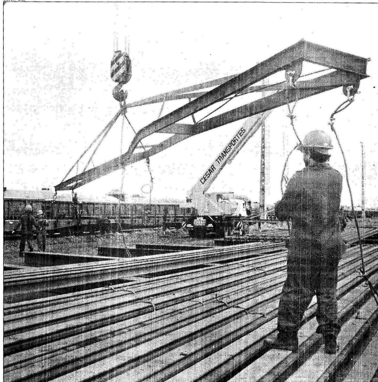
Vindos da Espanha, os trilhos foram armazenados atrás da Rodoferroviária antes de serem levados aos canteiros de obras
