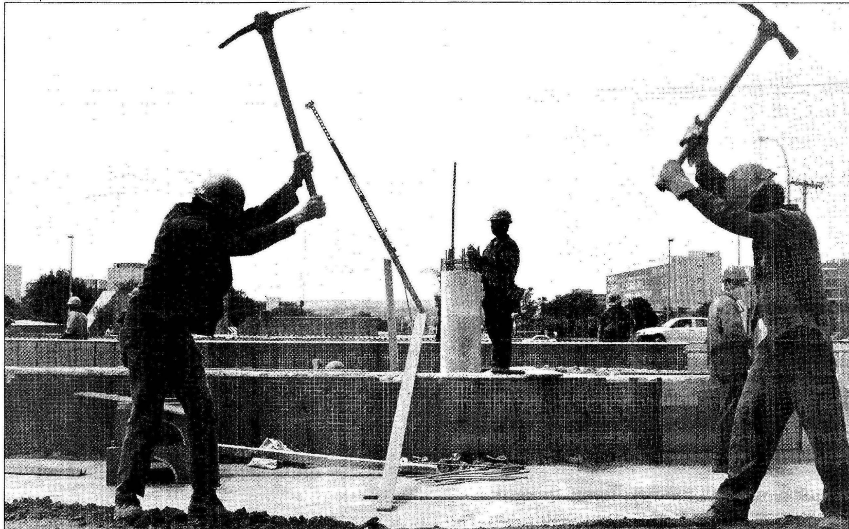
Desde a semana passada, a Estação 8 do metrô já está à vista. As sete outras do Plano Piloto vão aparecer a partir de hoje com a retirada dos tapumes
