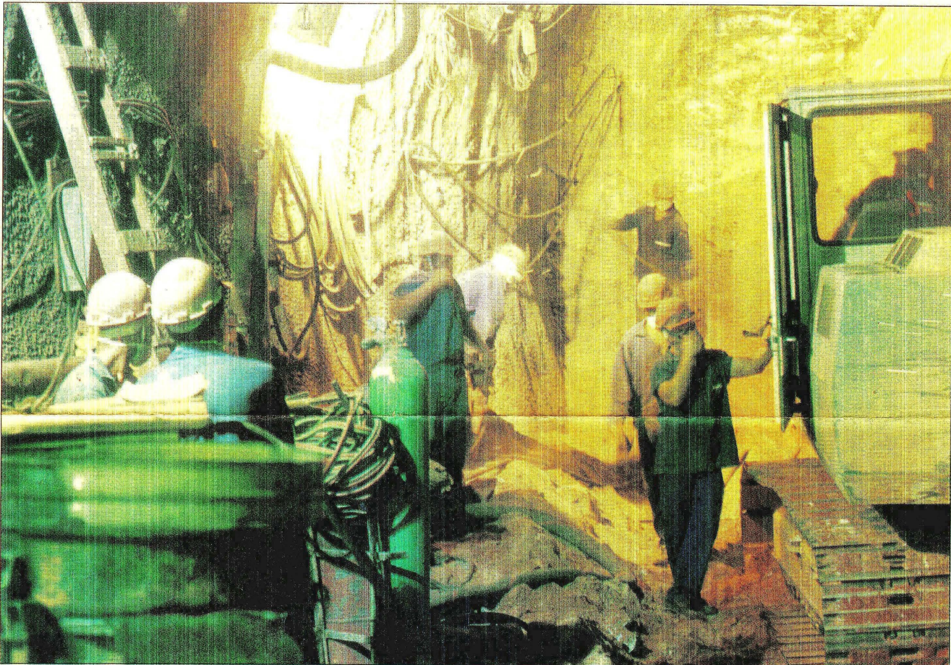
A 15 metros de profundidade, mais de 6 mil operários trabalharam para abrir os caminhos subterrâneos do metrô. As obras serão retomadas pela estação da Rodoviária
